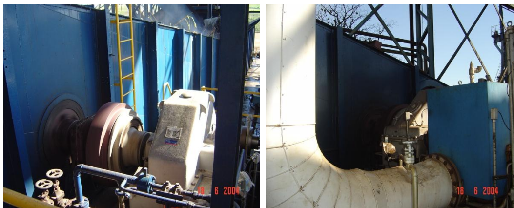
Figura 4.12: Picador e Desfibrador acoplados aos respectivos motores Elétricos
